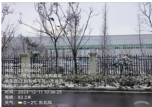
项目厂房南侧（城墙南路）
