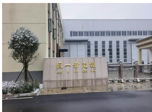
项目西侧 恒一新能源
