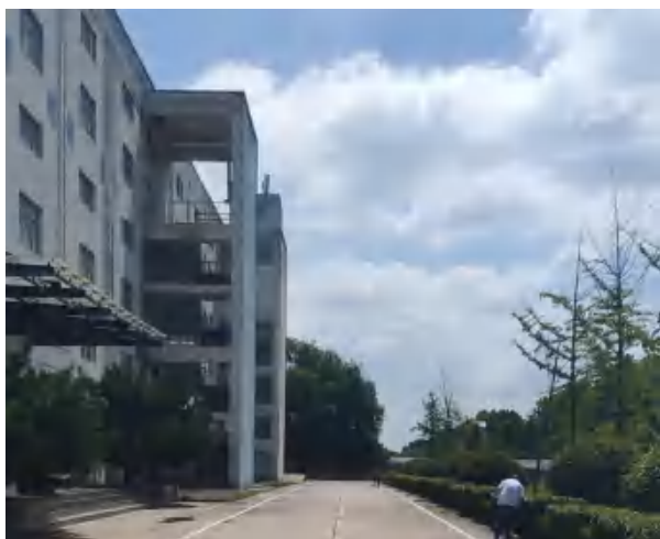
占用 1 号车间及南侧厂区道路、绿化
