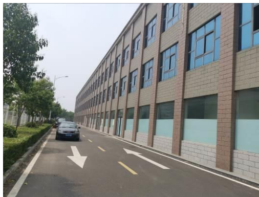
南侧 河南路路通不锈钢风帽厂及闲置厂房
