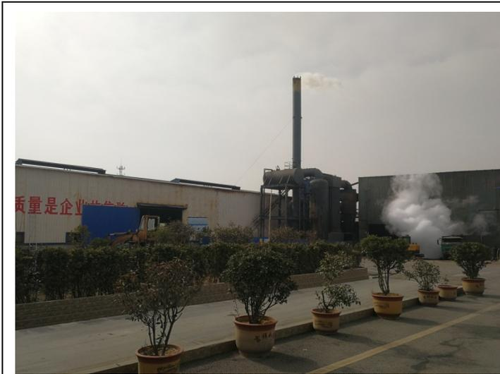
项目多管旋风除尘器+双碱法脱硫除尘+排气筒
